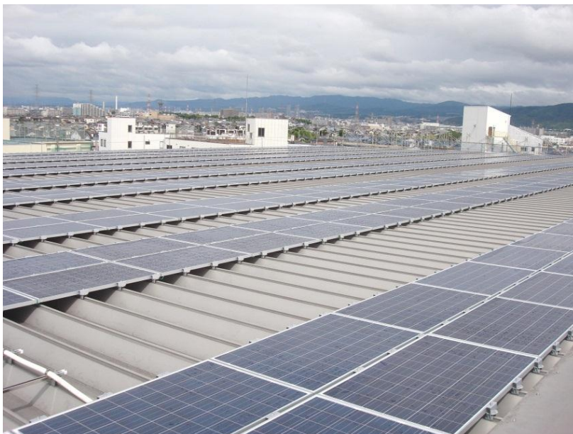
太陽光パネル設置全景
