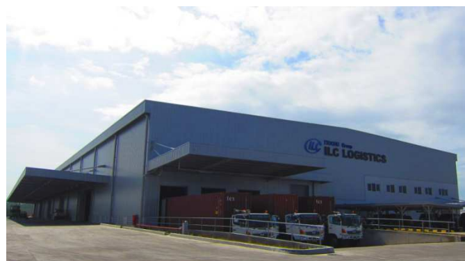
～ PT. ILC 新倉庫外観② ～
